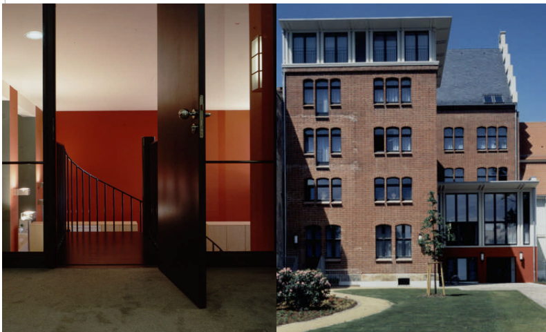
Hofseite des Gebäudes
